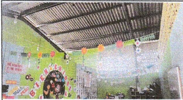
Foto 3: pintura de pared exterior e interior
