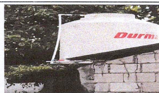
Foto 6: Cambio de deposito de agua
