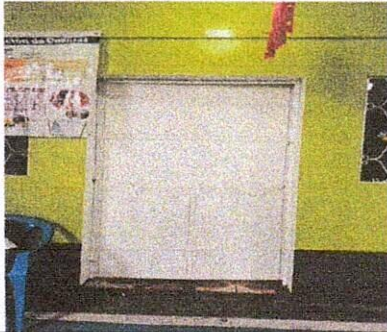
Foto 1: Cambio de sanitarios y pintura en puertas
