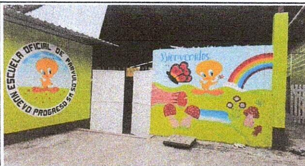
Foto 5: Mantenimiento de porton principal
